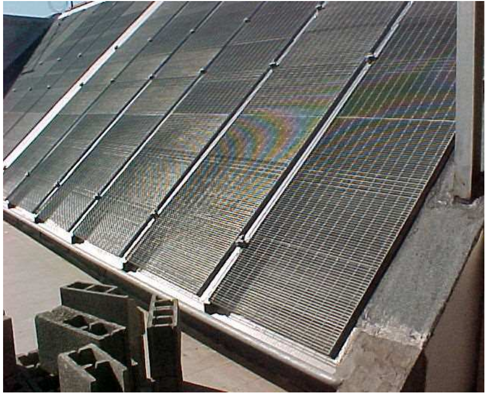
Nuovo Istituto Polifunzionale di Fiumicino (RM) Fasi realizzative di cantiere ( part. Brise-Soleil delle Aule Laboratorio)
