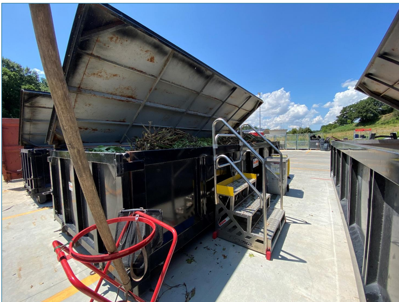
Figura 27 Cassa ubicata presso il Centro Comunale di Raccolta per il conferimento della frazione verde-sfalci
