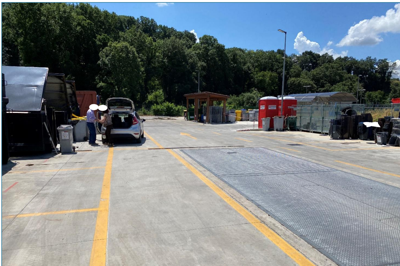
Figura 37 CCR via Salvatoretto. Area coperta per lo stoccaggio di materiali pericolosi, RAEE, oli esausti.
