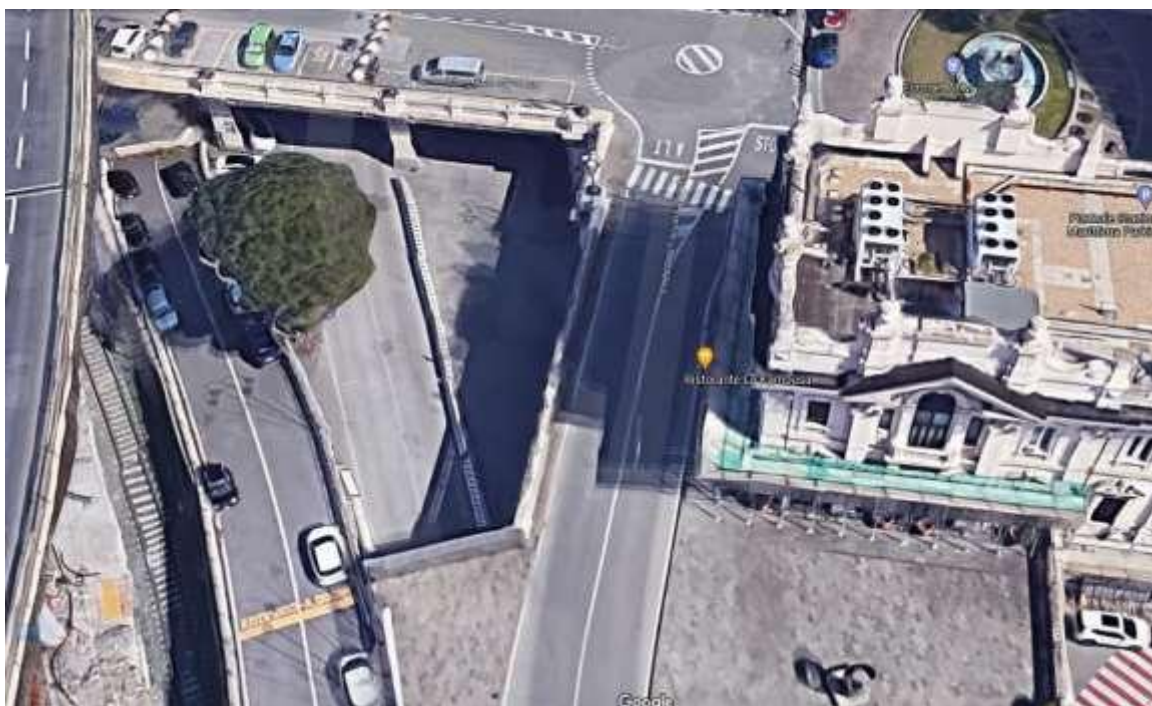
Foto 2 – Palazzo Santa Limbania – ADM DTII Sede Genova - Area esterna lato Ovest in prossimità della Stazione Marittima. La porzione di viabilità sulla sinistra individuata dalla segnaletica è assegnata ai mezzi dell'Agenzia delle Dogane
