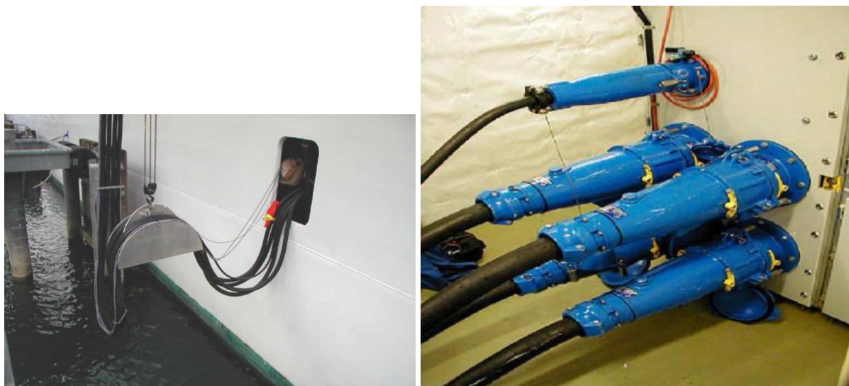
Figura 23 – Presa per il cavo di collegamento a bordo della nave
