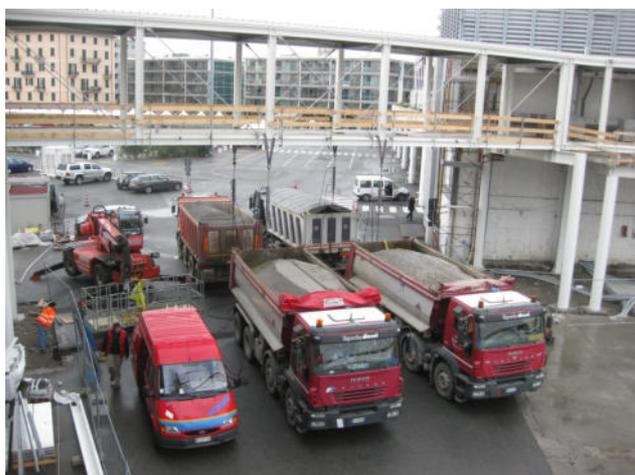
Prova di carico del Bridge di collegamento del nuovo Terminal al terminal esistente.
