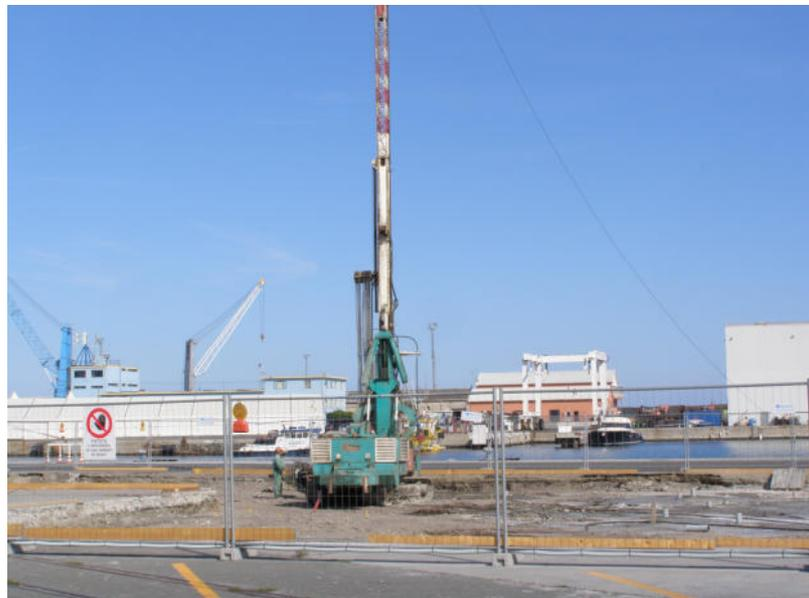
Realizzazione colonne di jet-grouting
