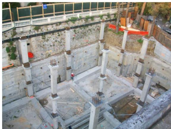
Fotografia del cantiere; sono visibili la paratia di monte, le fondazioni dirette e i pilastri in elevazione semi-prefabbricati
