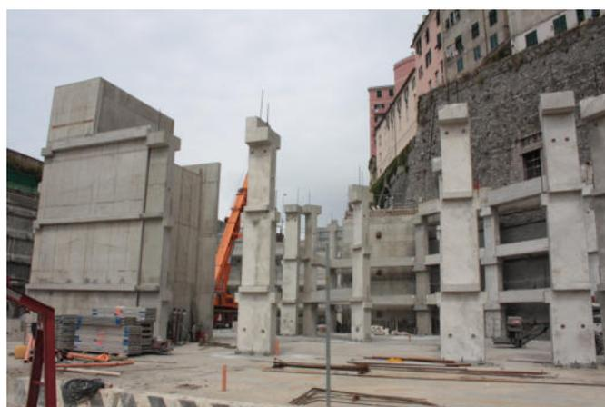
Vista delle strutture prefabbricate in elevazione in fase di montaggio.
